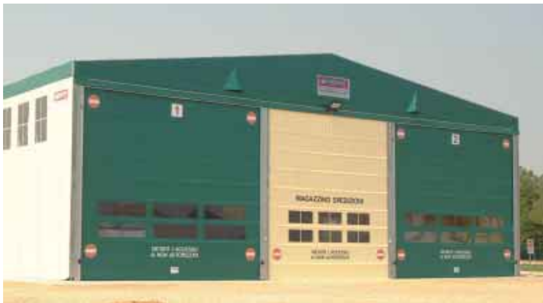
Porte rapide Quick-Door assemblate su capannone Cover-All Cramaro
